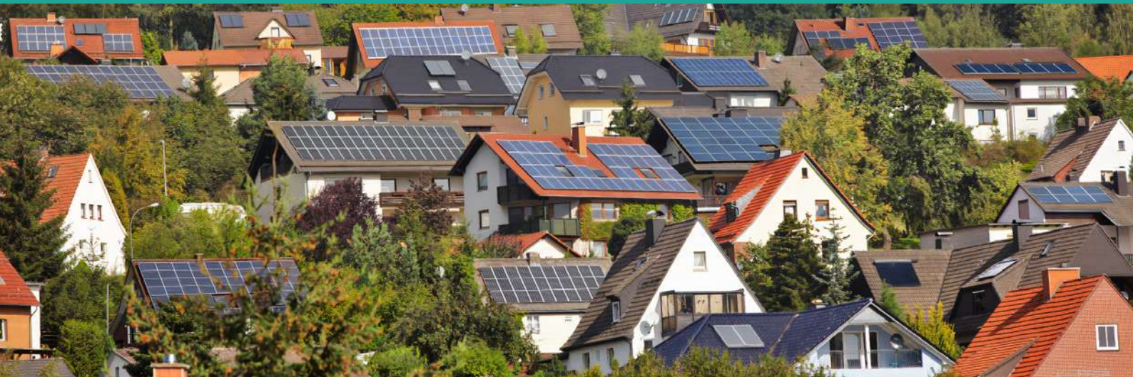
Vue sur les toits du quartier des Coteaux de Champigny
